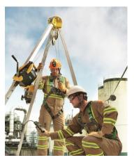
Un équipement particulier destiné à l'entrée en espace confiné ou de sauvetage peut être nécessaire pour faciliter l'entrée et la sortie dans le cas de travaux en espace confiné. Les systèmes de protection antichute appropriés pour les travailleurs se composent d'un ancrage (un trépied, par exemple), d'un harnais intégral et de dispositifs de connexion (comme une ligne de vie rétractable, un treuil ou une unité de sauvetage).
