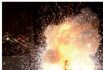
Arc flash 7 kA
