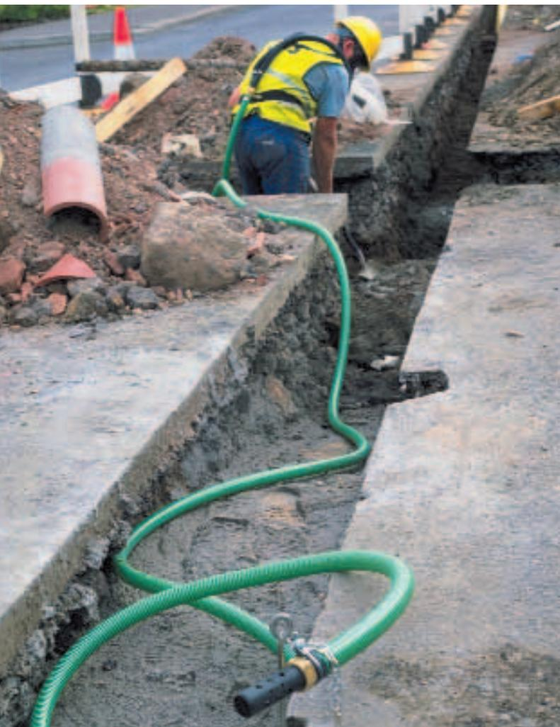
*Turbo-Flo als Saugschlauchgerät*
