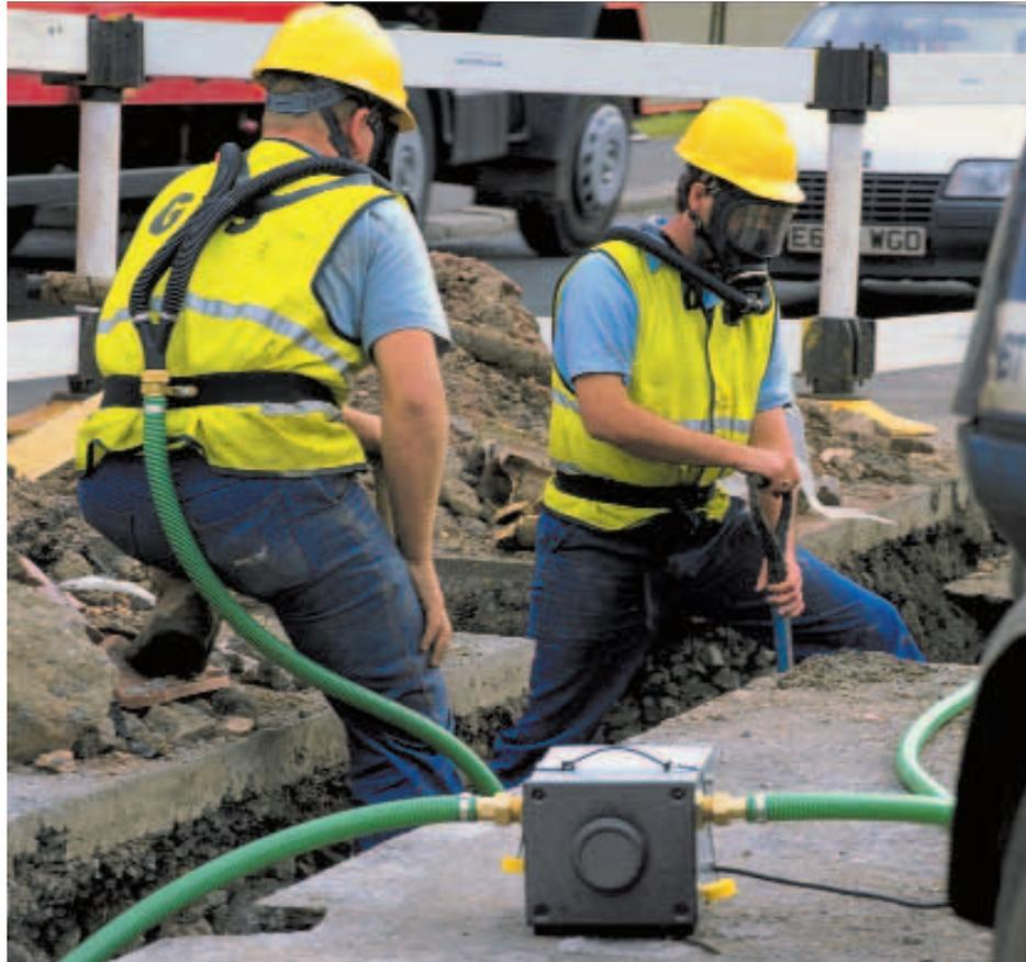
Turbo-Flo als Druckschlauchgerät
