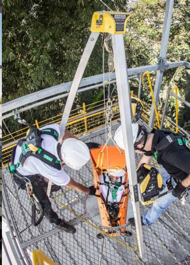
**Plano de resgate:** faz parte do sistema de proteção contra quedas. Deve ser de fácil e segura operação e realizado por profissional treinado e capacitado;
