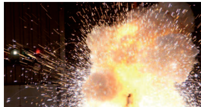
Arc flash 7 kA
