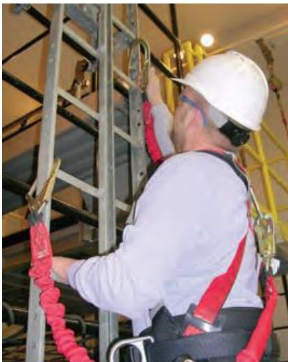
Acceso con líneas de vida con amortiguador Diamond doble
