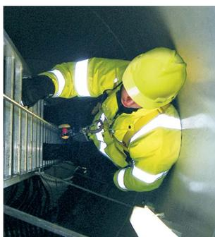
Quando si sale la scala di una turbina nuova o ammodernata, ci si può tranquillamente affidare al sistema TowerLatch MSA Latchways per offrire la soluzione ideale a mani libere, fissando l'utente al cavolo tramite l'anello a D sul torace dell'imbracatura integrale.
