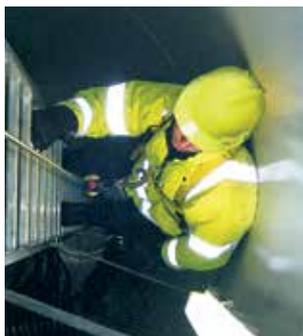
Lors de l'ascension de l'échelle d'une éolienne neuve ou renouvelée, faites confiance au système TowerLatch de MSA Latchways pour vous fournir la solution mains libres idéale en ancrant le grimpeur au câble grâce à l'anneau en D de poitrine de son harnais intégral.
