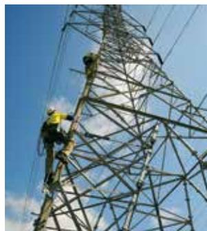
Suffisamment flexibles pour répondre à tous les besoins en matière de sécurité des travaux en hauteur, les systèmes verticaux Latchways sont parfaits pour le personnel accédant aux pylônes de transmission à haute tension ou aux transformateurs dans les sous-stations.
