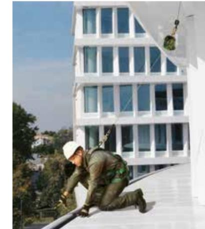
V-TEC™ Höhensicherungsgerät (SRL)
